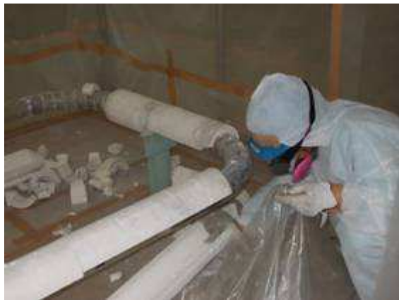
保温材の撤去
