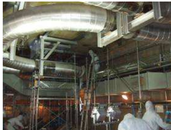
作業足場の設営
