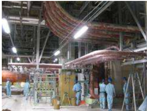
解体撤去機器・配管の保温撤去
