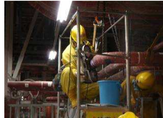
バンドソーによる配管切断作業
