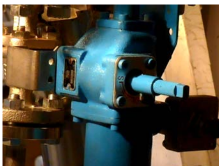
写真 3-1 爆砕用自動ボールバルブ (写真は「開」の状態)
