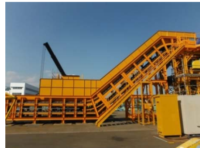
写真 1-3 傾斜コンベヤ
