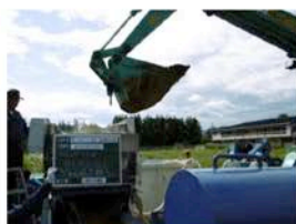
写真 3-6 30 mm以下の土壌投入の様子
