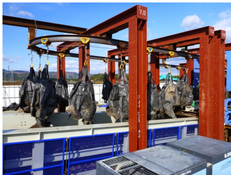
写真-3 フレキシブルコンテナの連続破袋完了状況
