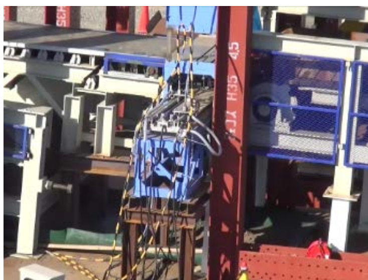
写真-14 ウォータージェットノズルのスライド状況
