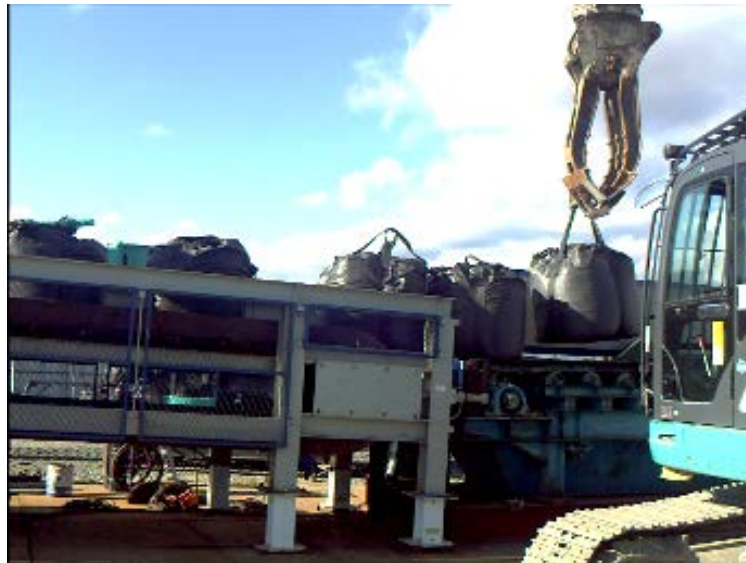
写真-12 グラップルによる積込状況（能力不足で供給コンベア上で玉突きできていない）
