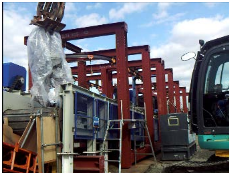
写真-7 多重(6重)フレキシブルコンテナ袋材掴み上げ状況 (φ 1300 の外袋は吊り下げで分離済み)
