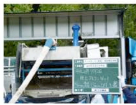
写真 3-8 5mm 超 15mm 以下の 土壌への分級の様子
