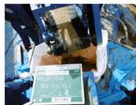
写真 3-9 5 mm以下の 土壌への分級の様子
