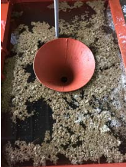
写真 2-4 浮上汚泥の回収
