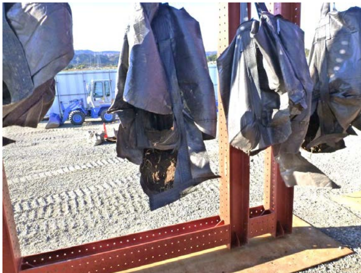
写真-13 破袋後の残留土壌の発生状況
