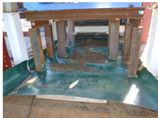
(b)連続破袋後の防液堤内部
