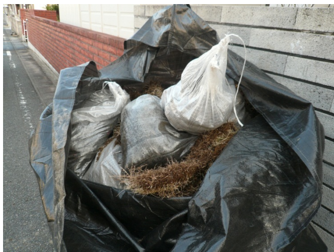
写真－11 土のう袋が詰められたフレキシブルコンテナの例
