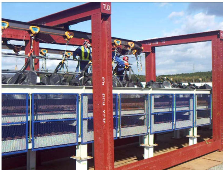
写真-15 フレキシブルコンテナの玉掛け作業状況
