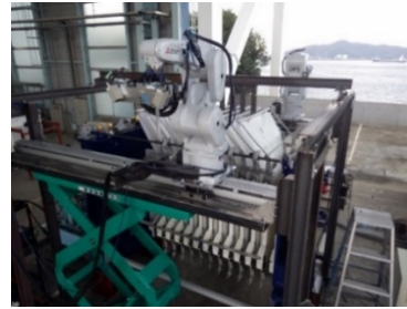
写真 3-18 ろ布吊り上げ完了
