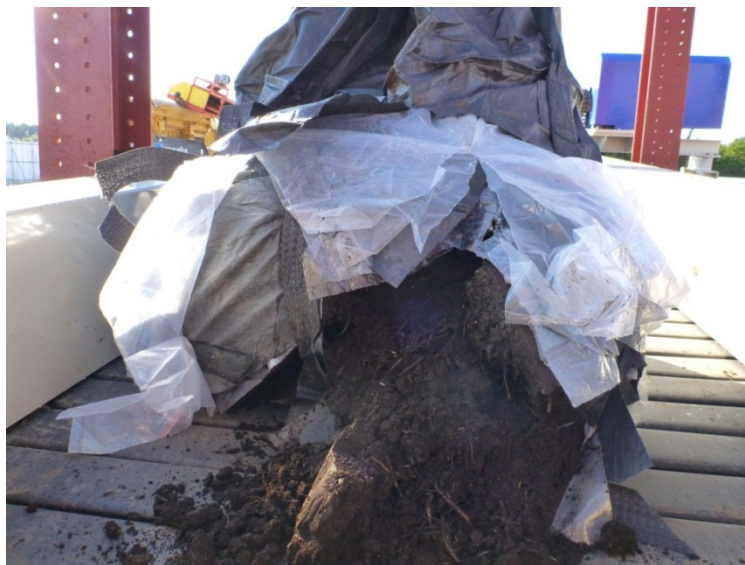
写真-6 φ 1300mm+φ 1100mm 多重(6重)フレキシブルコンテナ破袋状況
