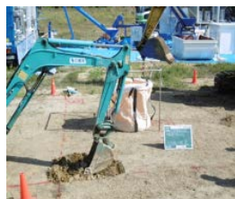
写真 3-1 土壌剥ぎ取り
