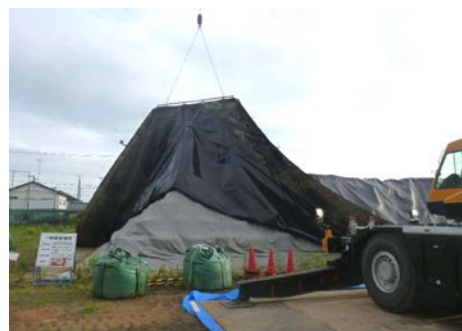
写真 1 一時保管場所の遮水シートめくり作業
