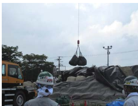
写真 2 フレキシブルコンテナ取出し
