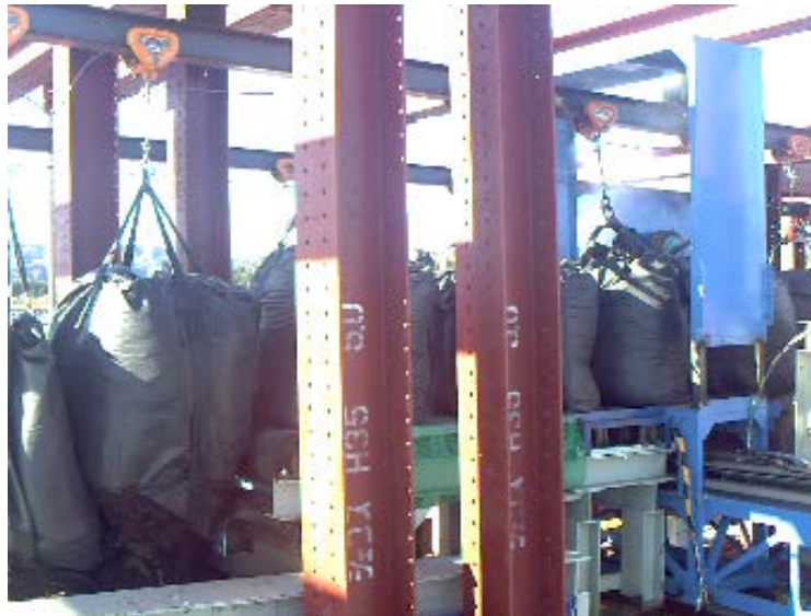
写真-2 フレキシブルコンテナ連続破袋状況の確認
