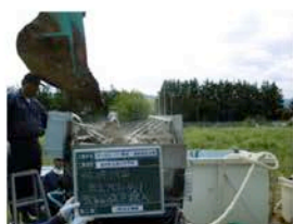
写真 3-7 15mm 超 30mm 以下の 土壌への分級の様子
