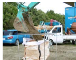
写真 3-2 原土フレキシブルコンテナ詰め
