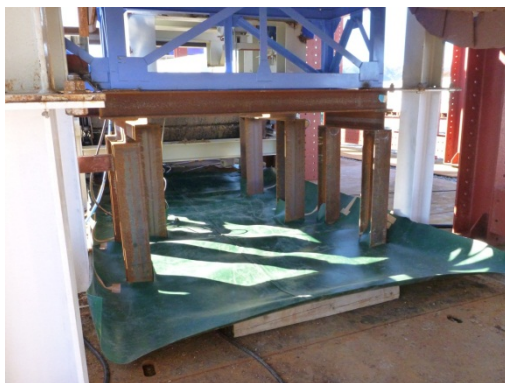
(a)連続破袋前の防液堤内部
